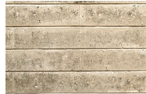
Ref.01 Bloques de gran formato colocados a rompe-juntas con junta vertical mínima y junta horizontal biselada
