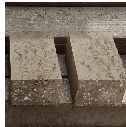
ACABADO DE LOS BLOQUES DE TIERRA CORTADOS FINISHING OF CUT EARTH BLOCKS
