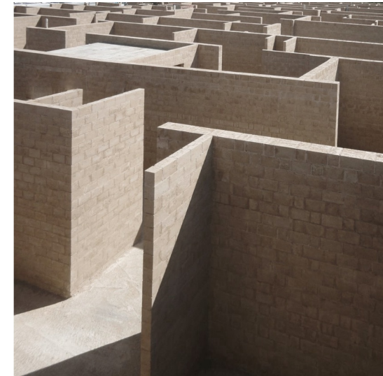
Ref.02 Combinación de muro simple y doble muro colocado como Aparejo flamenco Combination of simple and double wall laid using Flemish bond
