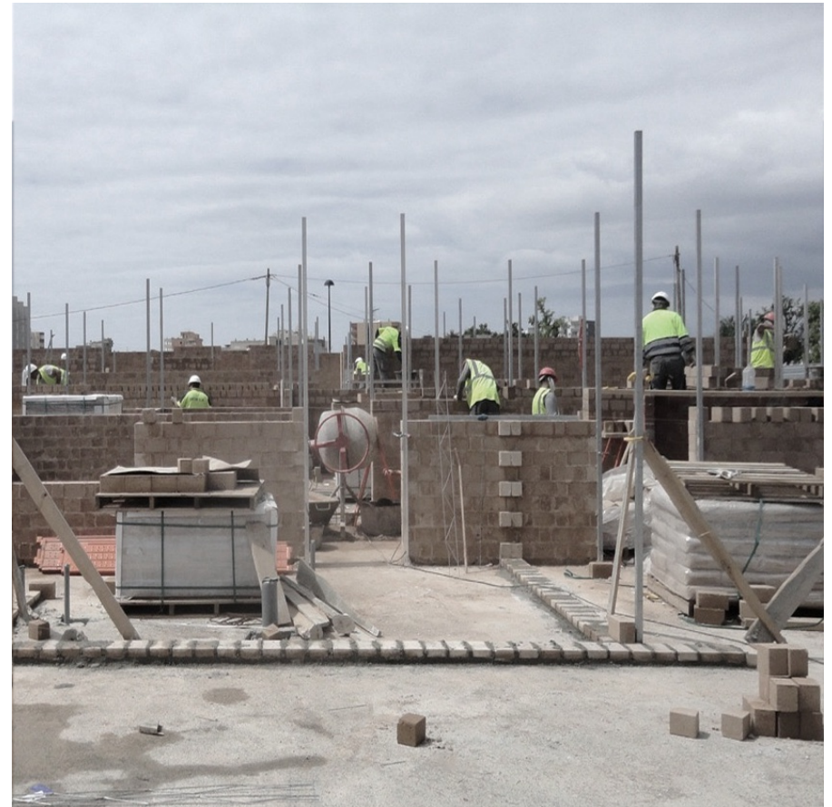
GUIA PARA LA EJECUCIÓN DE MUROS DE TIERRA CON BLOQUES PREFABRICADOS TAPIALBLOCK® DE FETDETERRA GUIDE FOR THE EXECUTION OF EARTH WALLS WITH TAPIALBLOCK® PREFABRICATED BLOCKS FROM FETDETERRA
